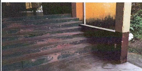
FOTO 4: Suministro de pasamanos de metal h: 1.00
