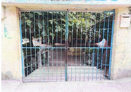
FOTO 1: Sustrucción de portón de metal de ingreso principal de 2.00 x 2.50
