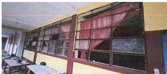
FOTO 2: Suministro de balcones de metal y ventanas pvc
