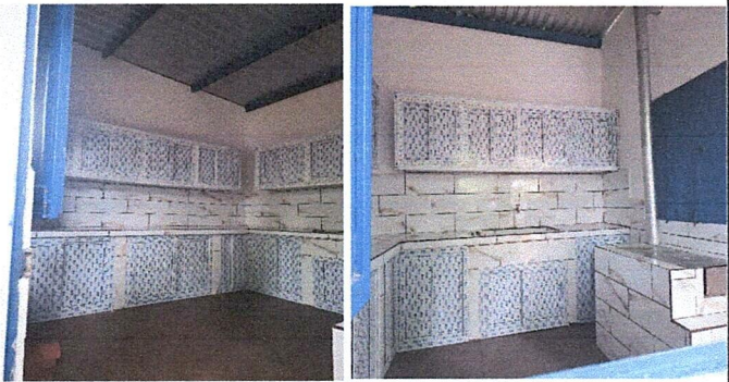
Foto1: Aplicación de cernido en paredes interiores de cocina, Suministro de gabinetes aereos de 7.00 x 0.60 x 0.80, Suministro de estufa rural de 0.60 x 2.00 x 0.80 (incluye chimenea)
