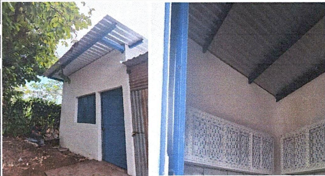
Foto 2: Sustitución de lámina, por lámina troquelada aluzinc calibre 26 + sustitución de estructura portante de metal
