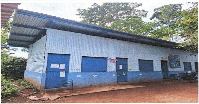
Foto 5: Sustitución de lámina, por lámina troquelada aluzinc calibre 26 + sustitución de estructura portante de metal (techado de lámina y área posterior de aulas)
