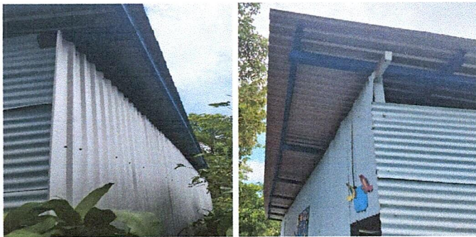
Foto 6: Sustitución de lámina, por lámina troquelada aluzinc calibre 26 + sustitución de estructura portante de metal (techado de lámina y área posterior de aulas)
