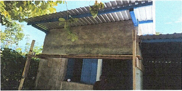
Foto 4: Sustitución de lámina, por lámina troquelada aluzinc calibre 26 + sustitución de estructura portante de metal
