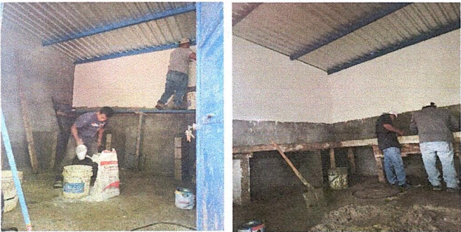
Foto1: Aplicación de cernido en paredes interiores de cocina, Suministro de gabinetes aereos de 7.00 x 0.60 x 0.80, Suministro de estufa rural de 0.60 x 2.00 x 0.80 (incluye chimenea)
