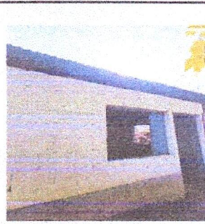
Foto 2: Sustitución de lámina, por lámina troquelada aluzinc calibre 26 + sustitución de estructura portante de metal
