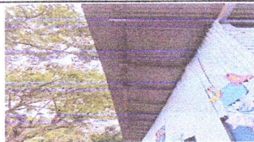
Foto 6: Sustitución de lámina, por lámina troquelada aluzinc calibre 26 + sustitución de estructura portante de metal (techado de lámina y área posterior de aulas)
