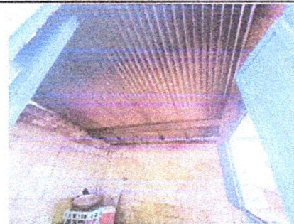
Foto 4: Sustitución de lámina, por lámina troquelada aluzinc calibre 26 + sustitución de estructura portante de metal
