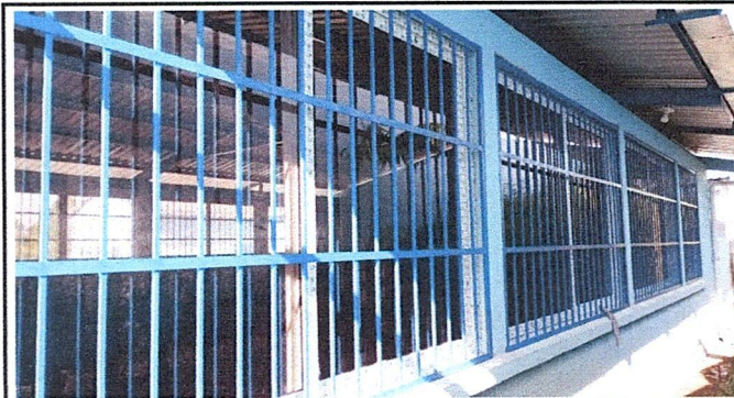
Foto 6: Sustitución de ventanas de metal con vidrio por ventanas de UPVC
