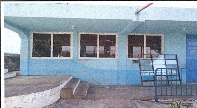
Foto 4: Sustitución de ventanas de metal con vidrio por ventanas de UPVC
