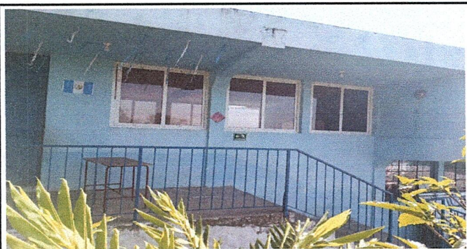
Foto 5: Sustitución de ventanas de metal con vidrio por ventanas de UPVC
