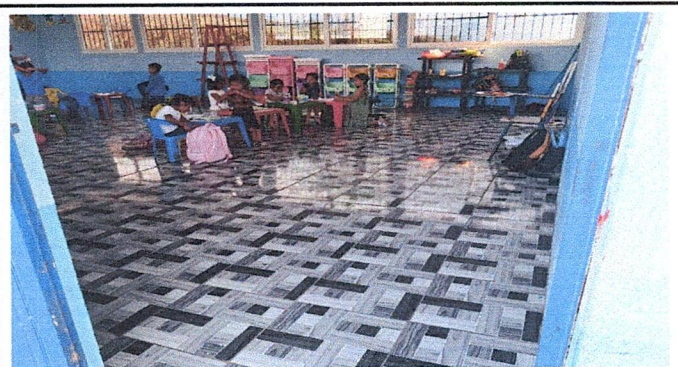
Foto 3: Sustitución de piso de torta de concreto po cerámico
