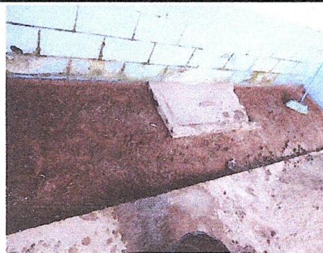
Foto 2: Sustrucción de piso de concreto deteriorado por torta de concreto
