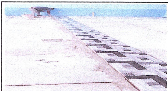
Foto 3: Sustrucción de piso de torta de concreto por cerámico
