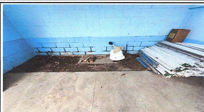
Foto 2: Sustrucción de piso de concreto deteriorado por torta de concreto
