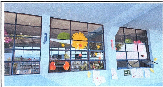
Foto 5: Sustrucción de ventanas de metal con vidrio por ventanas de UPVC
