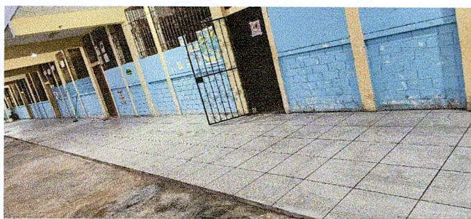
Foto 3: Sustitución de piso por Ceramica
