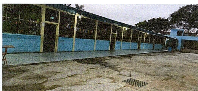
Foto 2: Sustitución de piso por Ceramica
