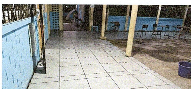
Foto 6: Sustitución de piso por Ceramica
