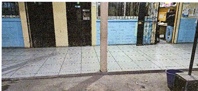
Foto 1: Sustitución de piso por Ceramica
