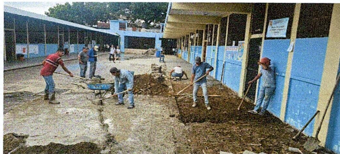
Foto 1: Sustitución de piso por Ceramica
