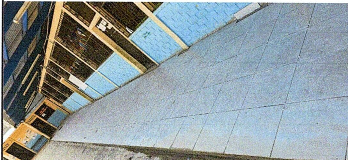
Foto 6: Sustitución de piso por Ceramica
