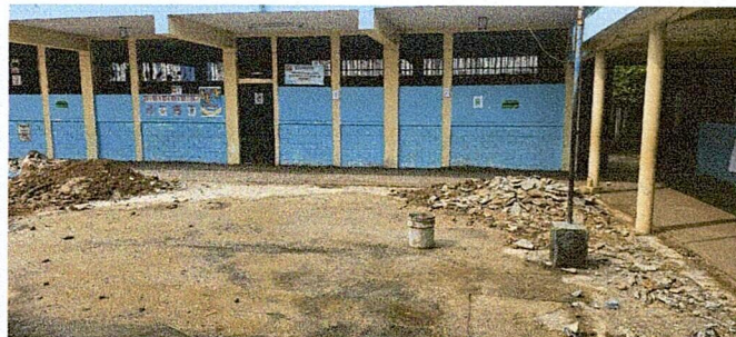
Foto 2: Sustitución de piso por Ceramica
