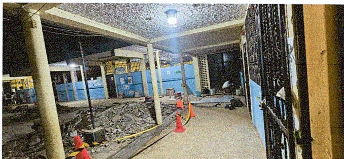
Foto 4: Sustitución de piso por Ceramica
