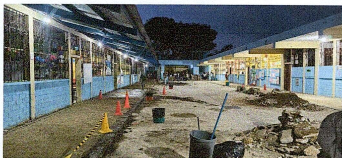
Foto 3: Sustitución de piso por Ceramica
