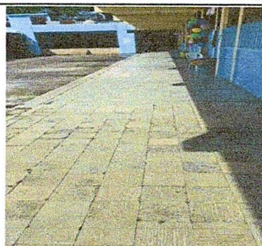
2. Sustitución de piso por piso ceramica
