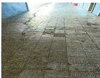
5. Sustitución de piso por piso ceramica
