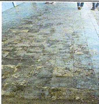
1. Sustitución de piso por piso ceramica
