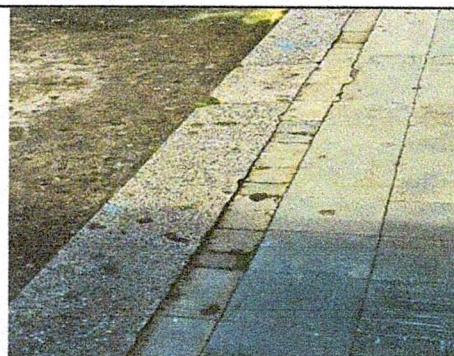
4. Sustitución de piso por piso ceramica
