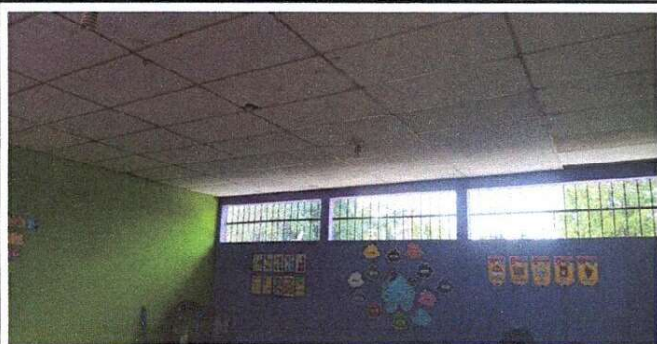
Foto 3: Suministro e Instalación de Tela metal en ventanas
