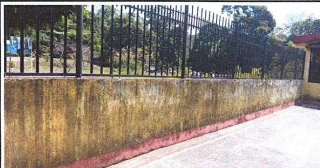
Foto 4: Pintura en Muros Exteriores e Interiores
