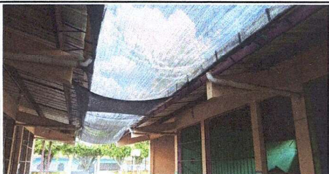
Foto 1: Sustitución de canal de PVC por canal de PVC. + bajadas de agua pluvial PVC
