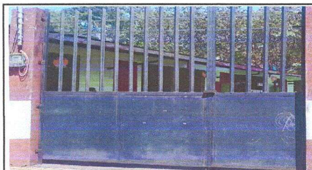
FOTO 5: MANTENIMIENTO DEL PORTON PRINCIPAL
