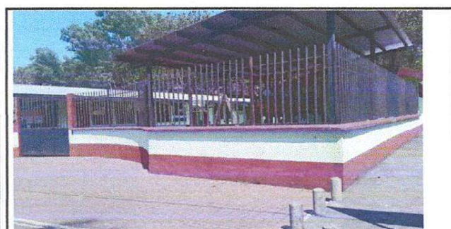
FOTO 5: APLICACIÓN DE PINTURA MURO EXTERIOR
