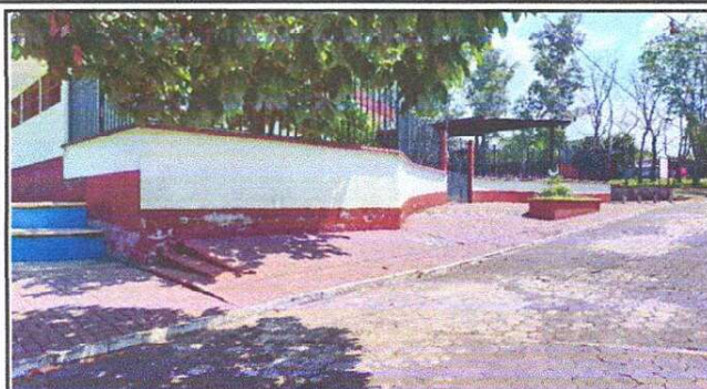
FORO 1: CONTINUACIÓN DE MURO EN LA PARTE FRONTAL DEL ESTABLECIMIENTO
