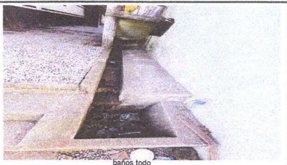
Foto: Reparacion de cunetas de concreto
