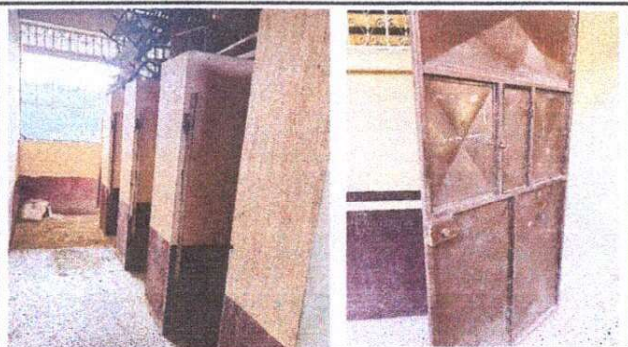
Foto 1: Sustitución de chapas en puertas de sanitario y portón
