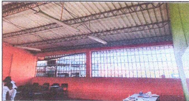
Foto 2: Renglón 5. ventanas: colocacion cortinas enrollables de metal en 3 aulas.
