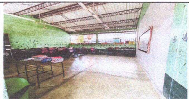
Foto 3. sustitucion de pizo de torta de cemento por pizo ceramico
