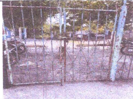
Foto 8: Sustitucion de porton
