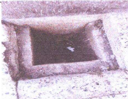
Foto 11: Reparacion de red de agua potable
