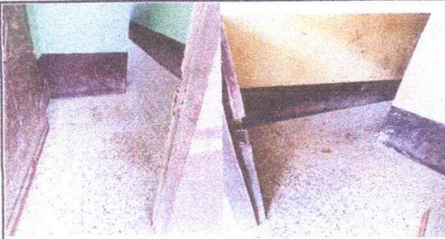
Foto: 9 Sustitucion de pizo de granito por pizo ceramico 2.5x8
