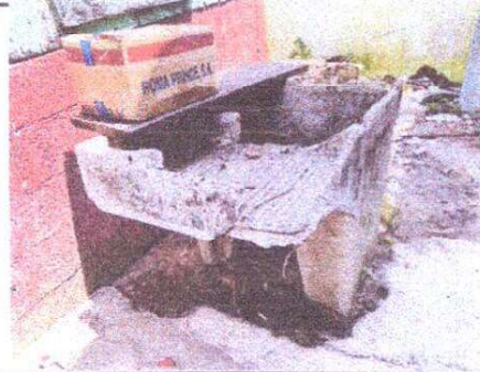
Foto 12: Sustitucion de pila de dos lavaderos
