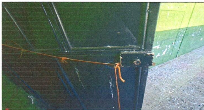
Foto 3: Sustitución de Chapas de puerta de aulas (Incluye instalación)
