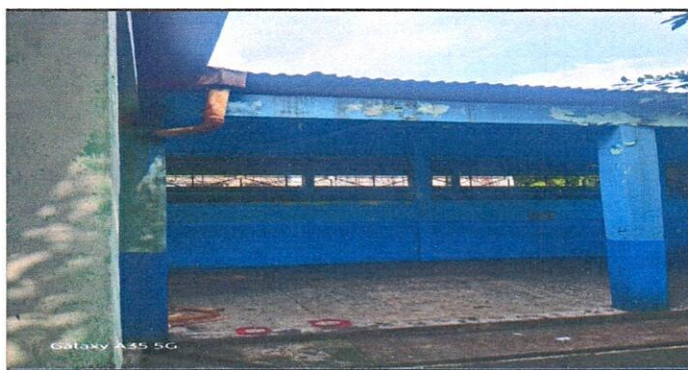
Foto 6: Sustitución de canales PVC por canales de metal (Incluye sujeción + pescantes)
