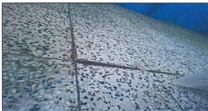
Foto 5: Reparación de piso de granito
