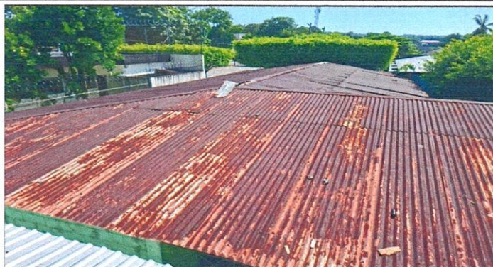
Foto1: Se realizara la sustitución de cubierta de lámina
