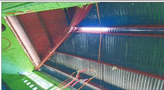
Foto 2: Se realizara el mantenimiento a estructura de techo
