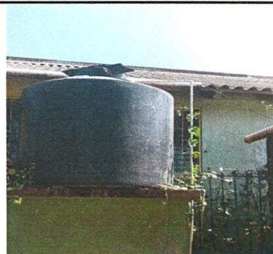
Foto 4: Sustitución de accesorios depósitos de agua potable (incluye accesorios tubería y accesorios)
