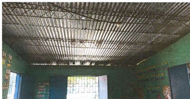
Foto 1: Sustitución de lámina, por lámina troquelada aluzinc calibre 26 y Sustitución de estructura portante de metal por metal
