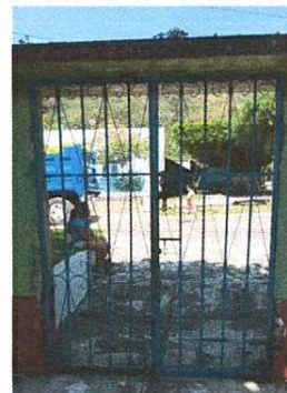
Foto 2: Sustitución de portón de metal por portón de metal de 1.47*1.94 mts. De dos hojas
