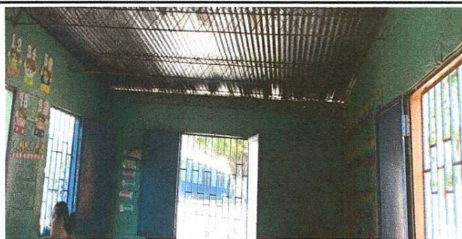
Foto 3: Instalación de ventanas PVC en aula No.3
