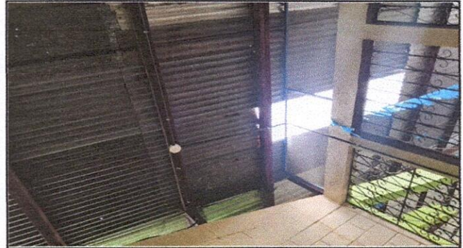
Foto 2: Se realizara el mantenimiento a estructura de soporte de techos
