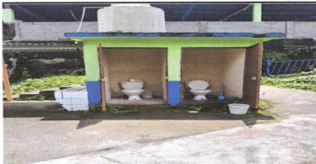
Foto 5: Se realizara la instalación de azulejos en servicios sanitarios + el cambio de piso de cemento por piso ceramico antideslizante
