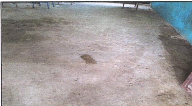
Foto 3: Se realizara la sustitución de piso en mal estado por piso cerámico
