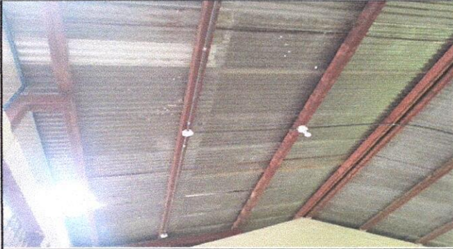
Foto 1: Se realizara la sustitución de laminas por lamina troquelada calibre 26
