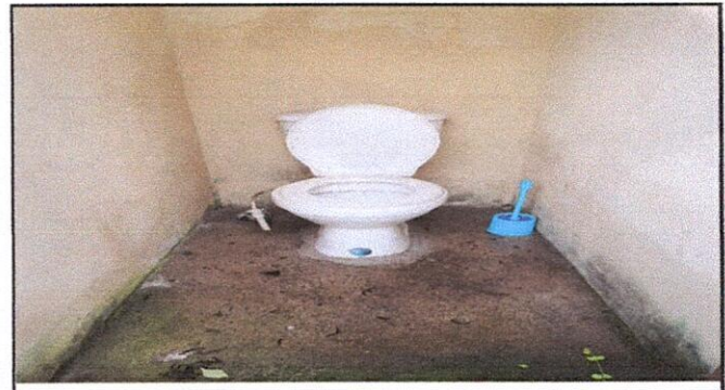
Foto 4: Se realizara Se realizara la sustitución de piso en mal estado por piso cerámico
