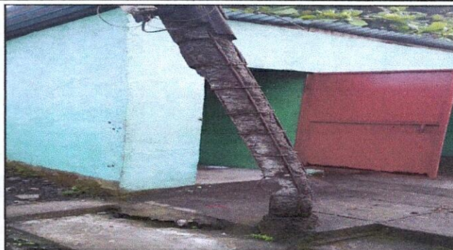
Foto 2: Reparación de muro de base de contador eléctrico
