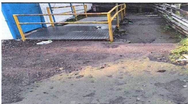
Foto 3: Mejoramiento de rampa de concreto
