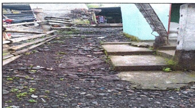
Foto 4: Reparación de gradas de concreto
