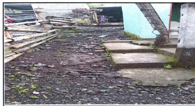
Foto 6: Suministro de pila de concreto fabricado en el área de servicios sanitarios
