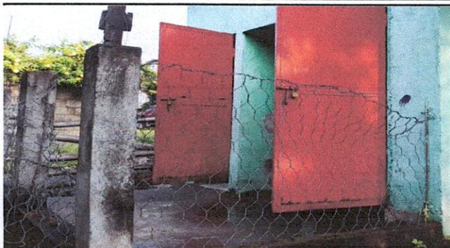
Foto 1: Sustrucción de malla galvanizada de 1 1/2 pulgada
