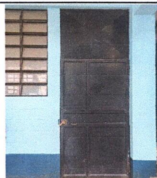
Foto 2: Mantenimiento de puertas.
