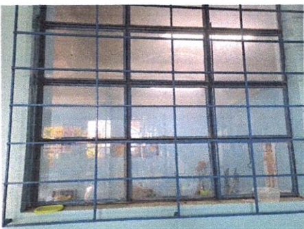
Foto 3: Mantenimiento a ventana de metal y vidrio.
