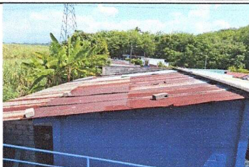
Foto 1: Sustitución de cubierta de lámina por láminada troquela aluzinc calibre 26
