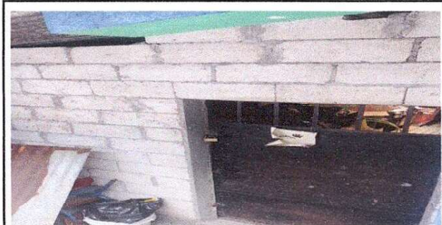
Foto 6: Cambio de ubicación de de puerta + mantenimiento (incluye cepillado, lijado y aplicación de pintura)
