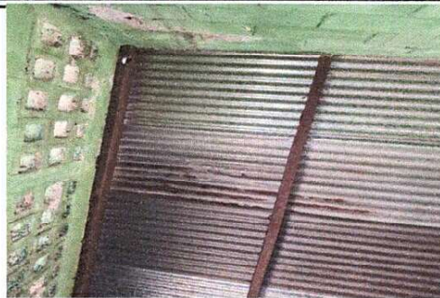
Foto 2: Sustitución de soporte de cubierta de metal por metal
