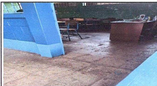
Foto 4: Sustitución de piso de granito por piso de granito en aulas
