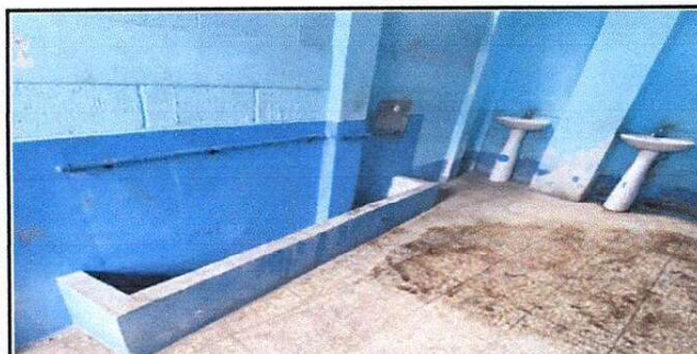
FOTO 5: REPARACIÓN Y MANTENIMIENTO DE MIGITORIO Y LAVAMANOS + SUMINISTRO DE INSTALACIÓN DE DEPOSITO DE AGUA POTABLE PARA LOS SERVICIOS
