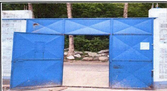
FOTO 1: SUMINISTRO DE CUBIERTA DE PORTON + MANTENIMIENTO A PORTON PRINCIPAL
