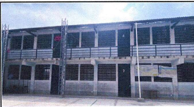
FOTO 2: REPARACIÓN Y MANTENIMIENTO DE BARANDA EN PASILLO DEL SEGUNDO PISO
