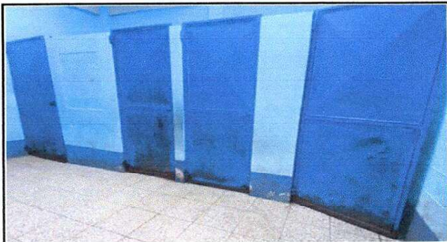
FOTO 3: REPARACIÓN Y MANTENIMIENTO A PUERTAS DE SERVICIOS SANITARIOS
