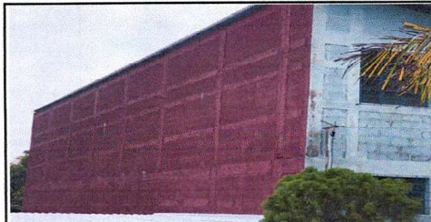
FOTO 6: APLICACIÓN DE PINTURA EN MUROS INTERIORES Y EXTERIORES DEL ESTABLECIMIENTO
