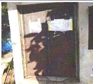
Foto 11: Sustitución de puerta de cocina.
