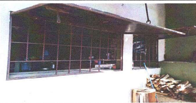
Foto 12: Mantenimiento a balcones de metal.
