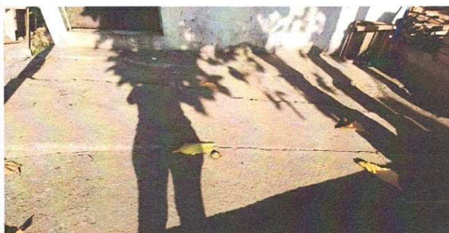
Foto 5: Sustitución de losa de patio, frente a la cocina.
