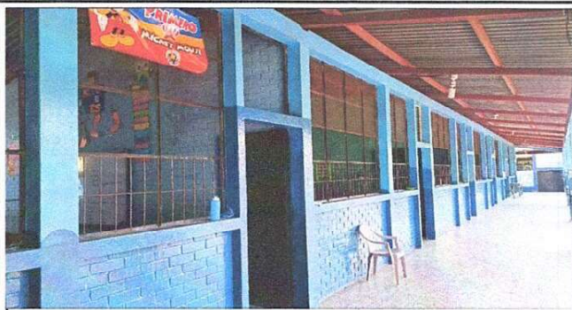
Foto 1 : Mntenimiento a estructura de metal de ventanas de aulas de adelante y atrás.
