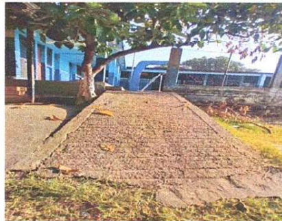
Foto 8: Sumnistro de barandas en rampa y gradas.
