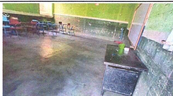
Foto 10: Aplicación de pintura en interiores y exteriores de aulas
