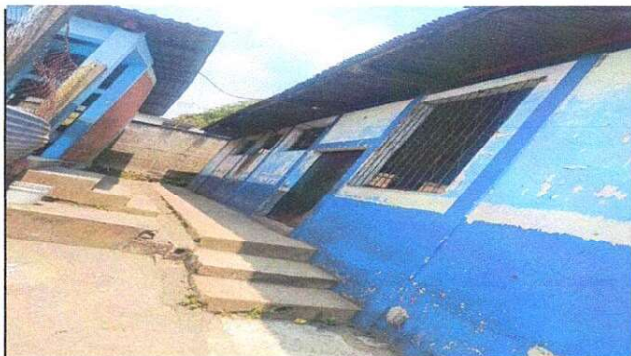
Foto 9: Reparación de banquetas frente al salon de usos múltiples.
