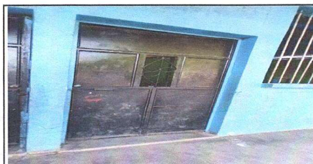
Foto 6: Mantenimiento d puertas en aulas , lijado, cambio de tubo, cepillado, sujeciones, aplicaion de pintura, cambio de chapa.
