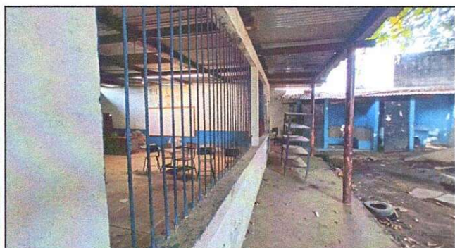
Foto 3 : sustitución de lámina troquelada aluzinc calibre 26
