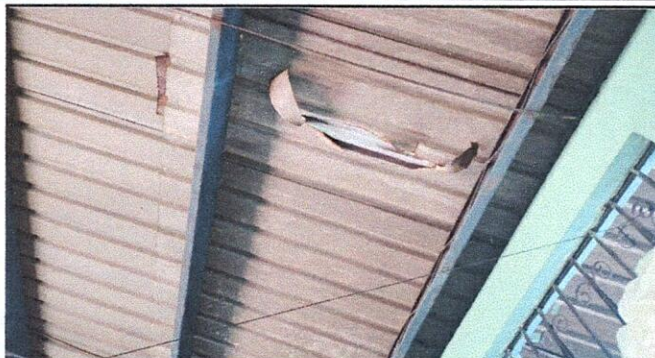
Foto 1: Sustrucción de lámina por lámina troquelada Aluzinc calibre 26 en área cocina, bodega + dos aulas
