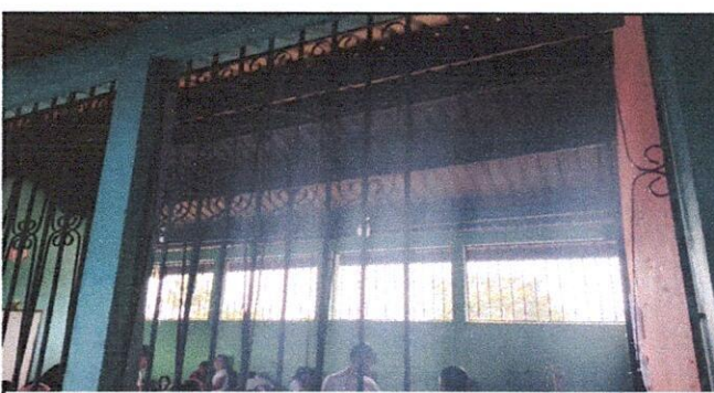
Foto 6: Reparación de balcón de metal (incluye complementos de varillas + aplicación de pintura)
