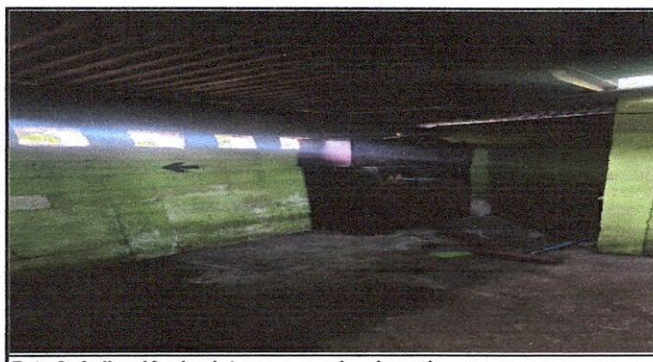
Foto 6: Aplicación de pintura en paredes de cocina
