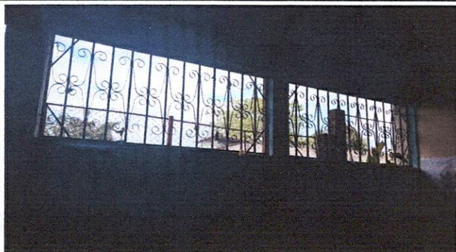
Foto 1: Suministro de ventanas de PVC de 0.81X1.03
