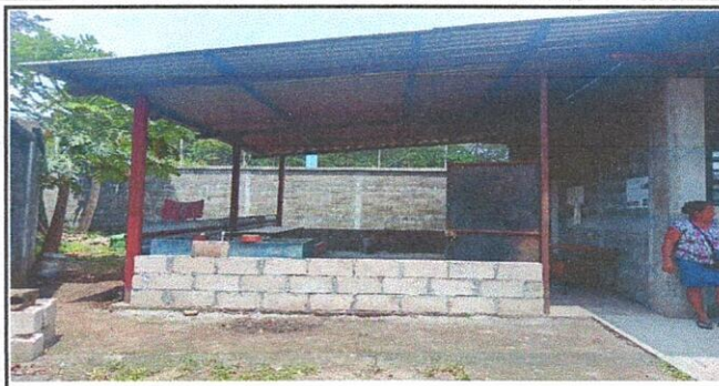
Foto 2: SUMINISTRO DE LOSA DE PATIO
