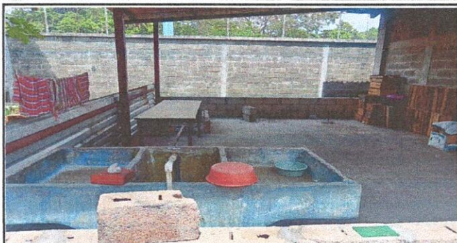
Foto1: SE REALIZARA LA INSTALACIÓN DE PISO DE GRANITO EN AREA DE COCINA
