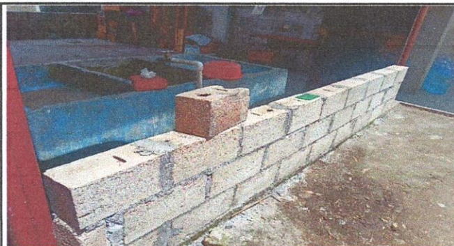
Foto 7: CONTINUACIÓN DE MURO DE BLOCK DE MEDIA ALTURAL EN COCINA POR SUSTITUCIÓN DE LAMINATA EXISTENTE.
