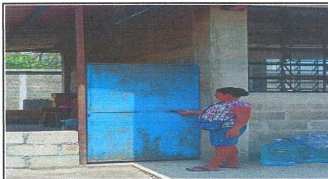
Foto 4: SE REALIZARA LA SUSTITUCIÓN DE PUERTA POR PUERTA TIPO REJA DE METAL
