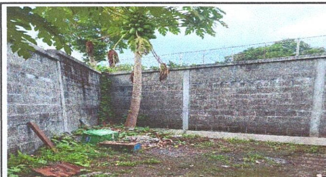
Foto 9: SUMINISTRO DE ESTRUCTURA DE CONCRETO DE DEPOSITO DE AGUA POTABLE
