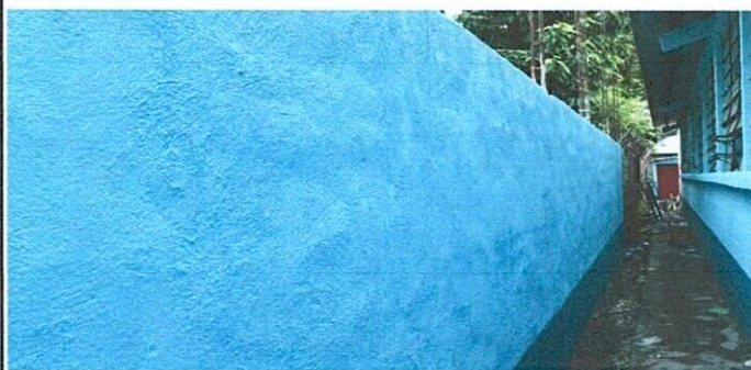
Foto 1: Culminación de Muro perimetral, cernido y pintado al 100%.
