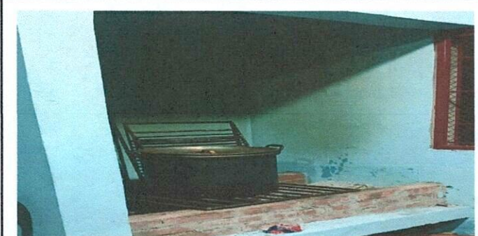
Foto 3: Finalización de estufa rural con Parrilla de metal y chimenea.
