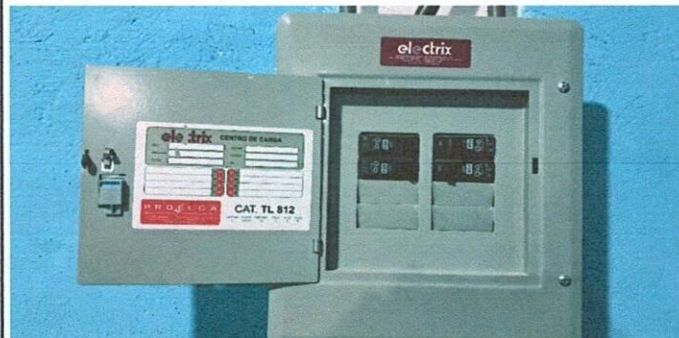
Foto 4: Colocación de tablero de 4 circuitos y filipones 100% culminado.
