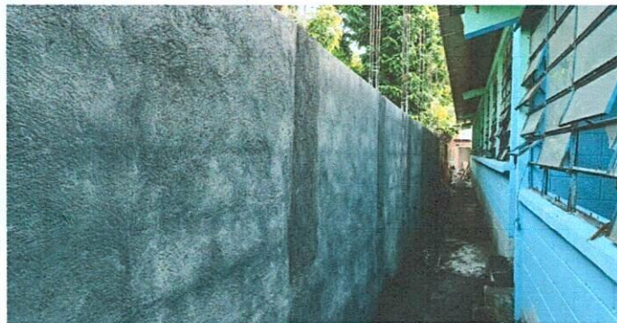
Foto 1: Muro perimetral siendo reparado en el area del callejón peatonal.
