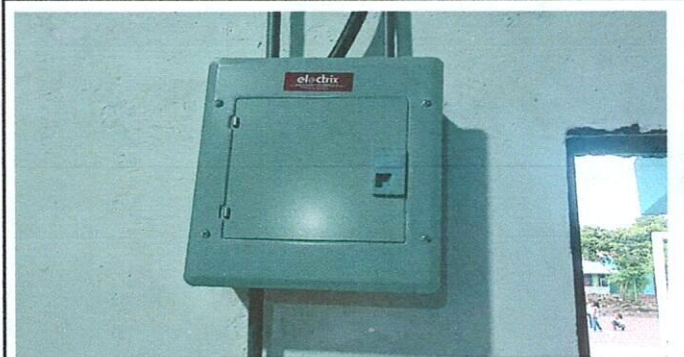
Foto 4: Instalación de tablero para organizar el sistema electrico en la dirección.
