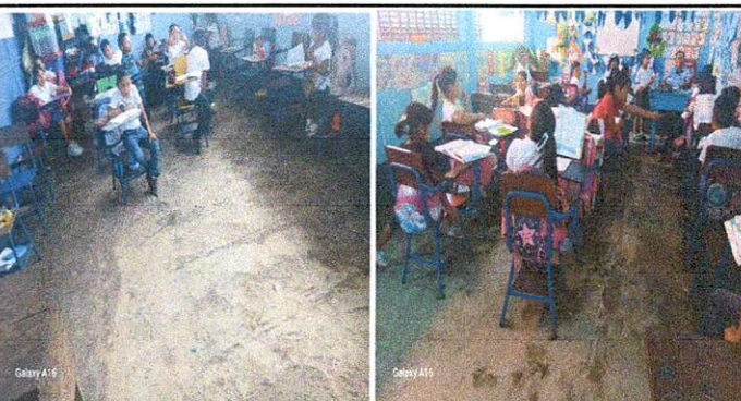
Foto 4: Sustitución de piso liso a cerámico aula de tercero sección B.
