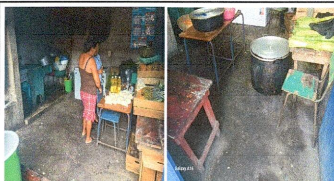
Foto 2: Sustitución de piso rustico a cerámico de la cocina.
