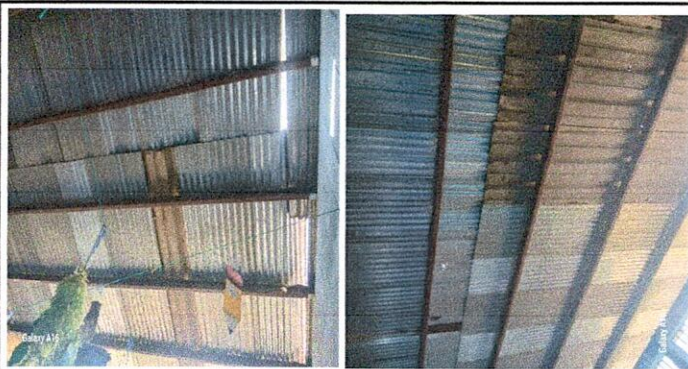
Foto1: Sustitución de laminas acanaladas a troquelada
