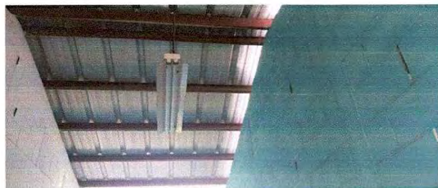
Referencia renglón 2.3 (sustitución de lamparas de baño)
