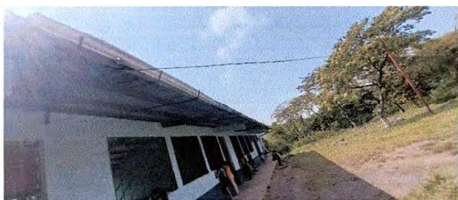
Referencia renglón 4.1 (sustitución de canal de metal).
