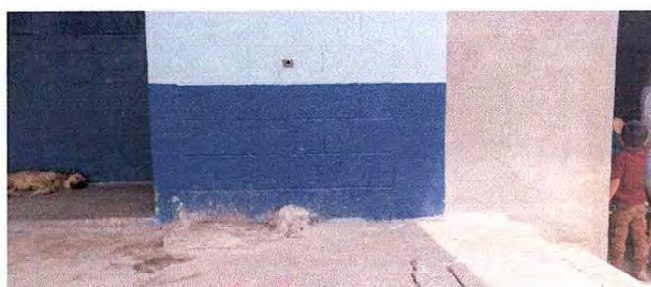
Referencia renglón 4.3 (suministro de pila de 2 fregaderos en patio)
