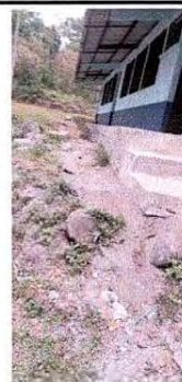
Referencia renglón 4.4 (suministro de cuneta de concreto en patio)
