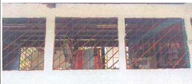
Referencia renglón 1.4 (mantenimiento de balcones)
