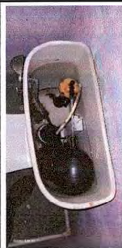
Referencia renglón 2.4 y 2.5 (sustitución de accesorios en tasas sanitarias y lavamanos).
