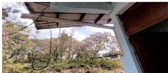
Referencia renglón 4.2 (sustitución de bajadas de agua pluvial).
