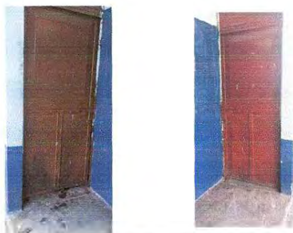
Referencia renglón 2.2 (sustitución de puertas en baños)
