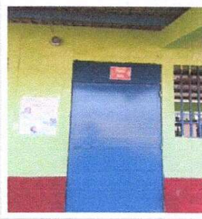
Foto 6: Mantenimiento de puerta de metal
