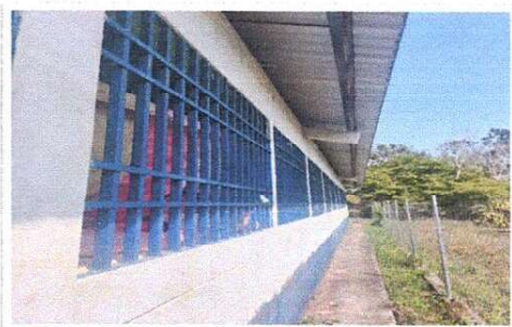
Foto 3: Mantenimiento de balcones mas suministro de ventanas PVC
