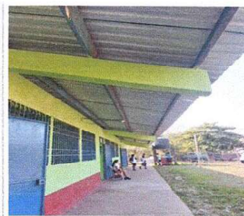
Foto 4: Sustitución de estructura y lámina cal.24 mas mantenimiento de balcones
