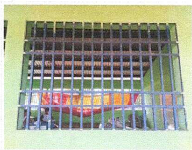
Foto 5: Suministro e instalación de ventanas
