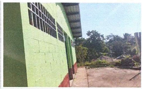
Foto 1: Mantenimiento de balcones
