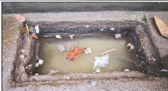
Foto 1: SE REALIZARA LA REPARACIÓN Y MANTENIMIENTO DE DRENAJE DE AGUA PLUVIAL
