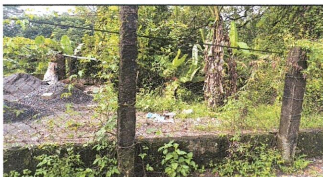
Foto 4: SE REALIZARA LA APLICACION DE REPELLO EN MURO PERIMETAL MAS SUSTITUCIÓN DE MALLA
