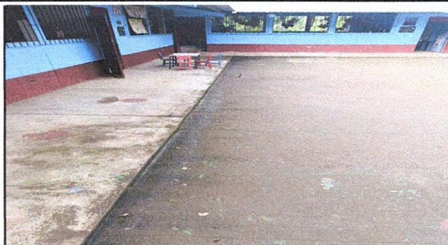
Foto 2: SE REALIZARA EL SUMINISTRO DE CAJAS DE REPOSADERA DE CONCRETO CON RATADERA DE METAL
