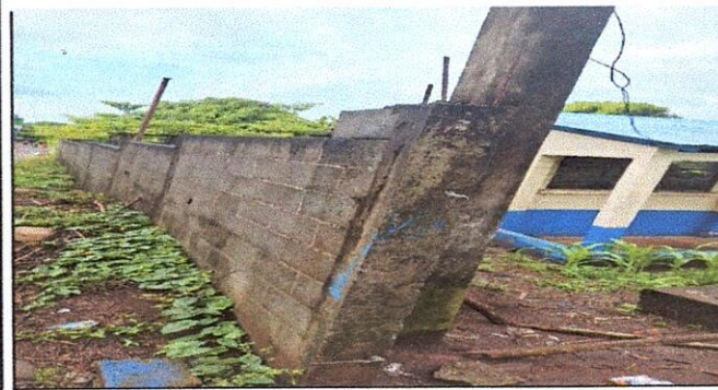
Foto 5: Se realizara la reparación de muro perimetral del establecimiento con continuación de muro de block
