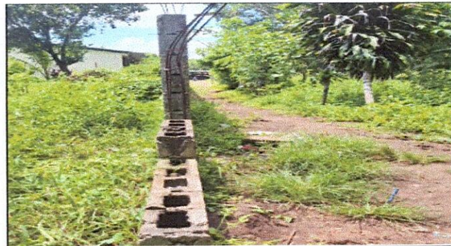
Foto 4: Se realizara la reparación de muro perimetral del establecimiento con continuación de muro de block
