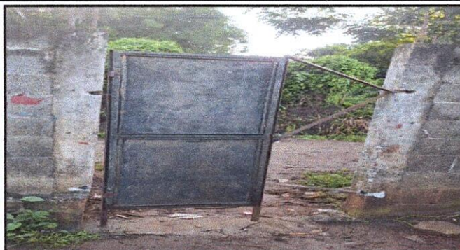
Foto 1: Se realizara la sustitución de portón del establecimiento
