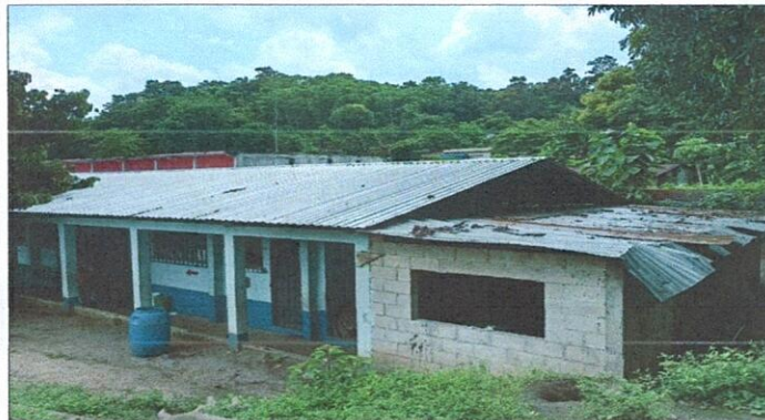
Foto1: SE REALIZARA LA SUSTITUCIÓN DE LAMINA EXISTENTE POR LAMINA TROQUELADA ALUZINC CALIBRE 26
