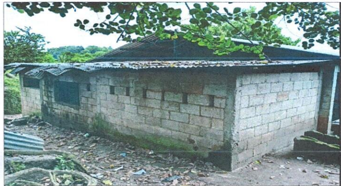
Foto 2: SE REALIZARA LA APLICACIÓN DE REPELO Y CERNIDO EN PAREDE DE NUROS DE COCINA
