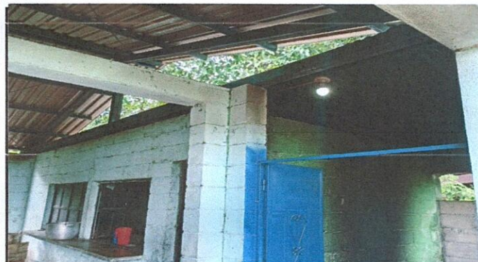
Foto 3: SE MEJORARA ALTURA DE COCINA CON MURO DE BLOCK
