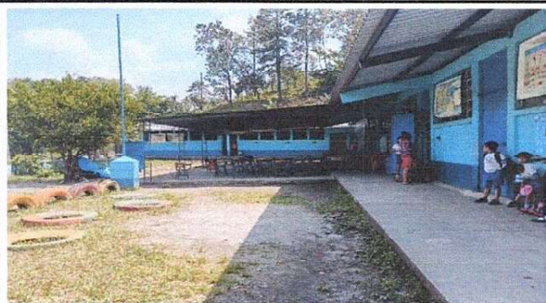
Foto 1: Reparación de planchas de concreto de patio.
