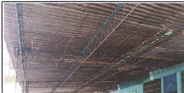
Foto 6: sustitución de estructura de soporte de metal, por metal.
