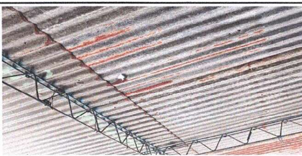
Foto 5: sustitución de lámina, por lamina troquelada.
