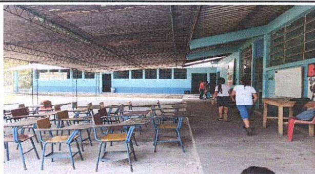
Foto 3: Sustitución de piso de torta de concreto.
