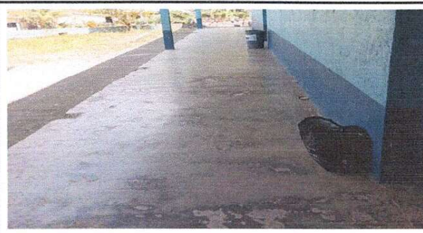
Foto 4: Sustitución de piso de torta de concreto.
