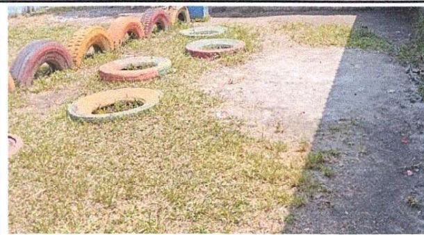
Foto 2: Reparación de planchas de concreto de patio.
