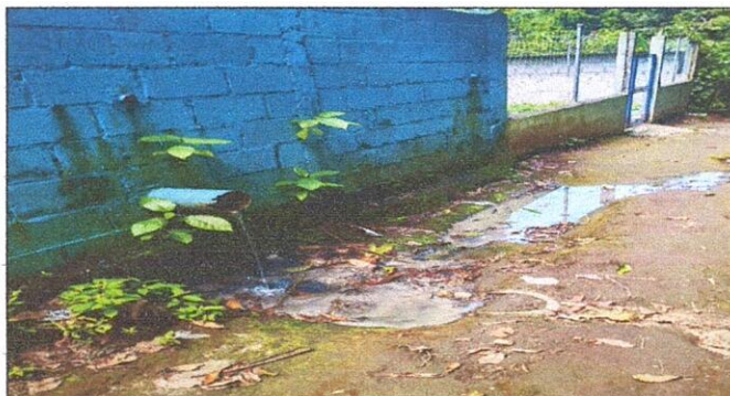
Foto 3: Se realizara la repación de tubería de drenaje existente en mal estado ya que afecta al paso peatonal.
