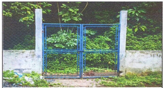
Foto 4: Sustitución de portón de malla por porton de estructura de metal 2.50m * 2.50 mts
