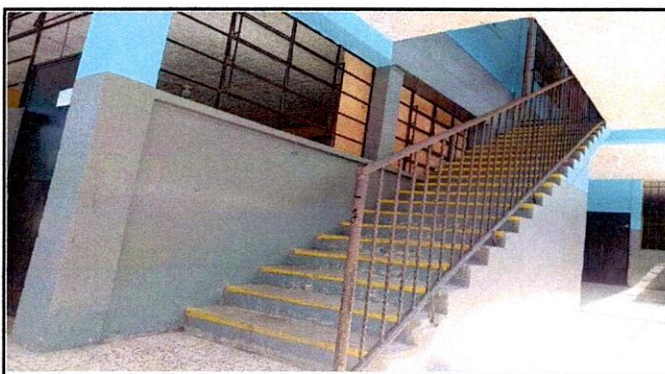
Foto 4: se realizara la repareparación de barandas de metal en segundo piso
