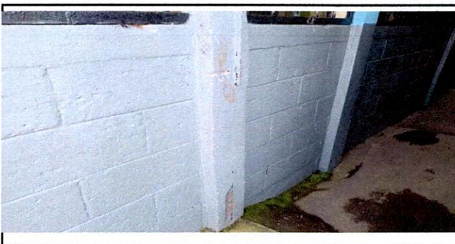
Foto 6: Se realizara la aplicación de repello en muros de dirección
