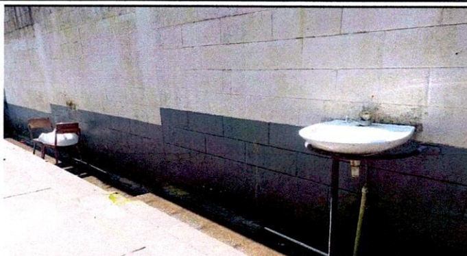
Foto 1: Se realizara el suministro de mueble de concreto + revestimiento para lavamanos empotrados de 0.60x1.50 mts
