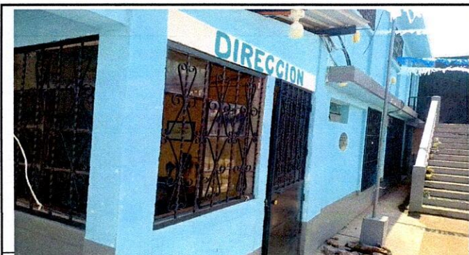
Foto 5: Se realizara la aplicacion de pintura en aulas, dirección y cocina
