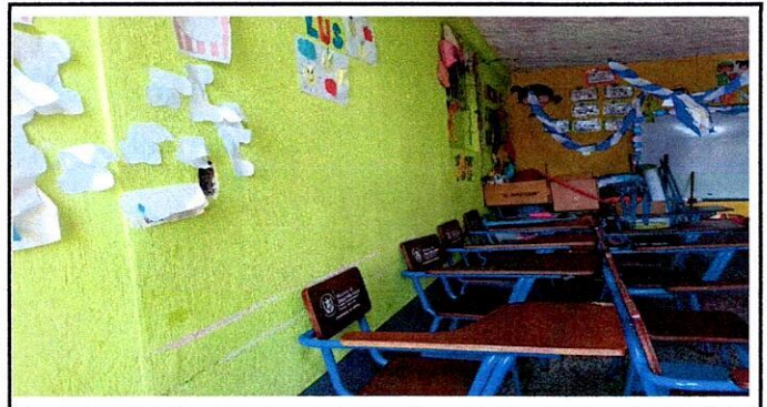
Foto 4: Se realizara la aplicación de pintura en aulas, dirección y cocina
