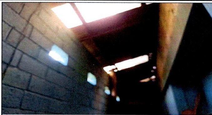
Foto1: Mejoramiento de voladizo de aulas hacia patio
