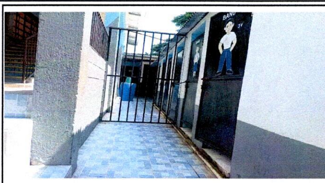
Foto 2: Se realizara la reparación de puerta de servicios sanitarios de 2.00X0.65 mts
