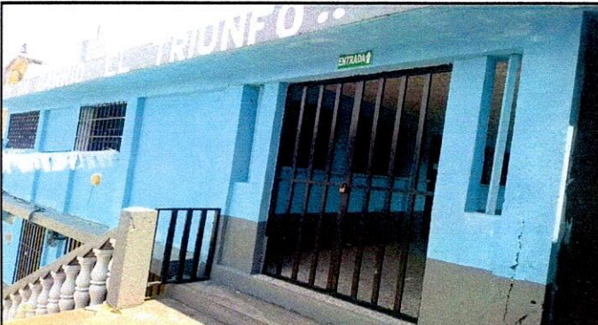
Foto 3: Se realizara la aplicación de pintura en aulas, dirección y cocina
