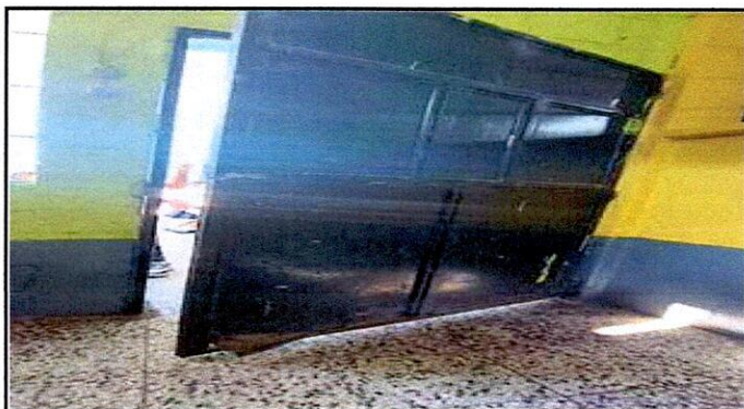
Foto 3: Reparación de puerta de cocina de 2.10x0.98 mts
