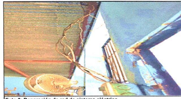
Foto 6: Reparación de red de sistema eléctrico
