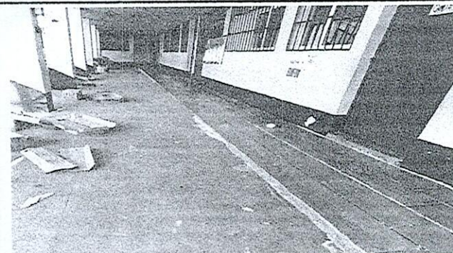
Foto 3: Sustrucción de piso de granito por piso cerámico en pasillo primer nivel.
