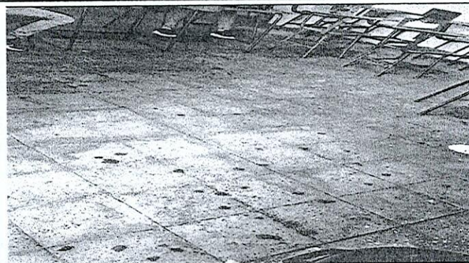
Foto 2: Sustrucción de piso de granito por piso cerámico en aulas primer nivel.
