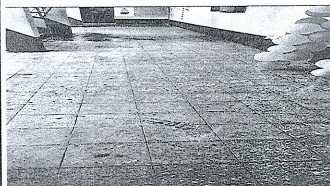
Foto 3: Sustrucción de piso de granito por piso cerámico en pasillo primer nivel.
