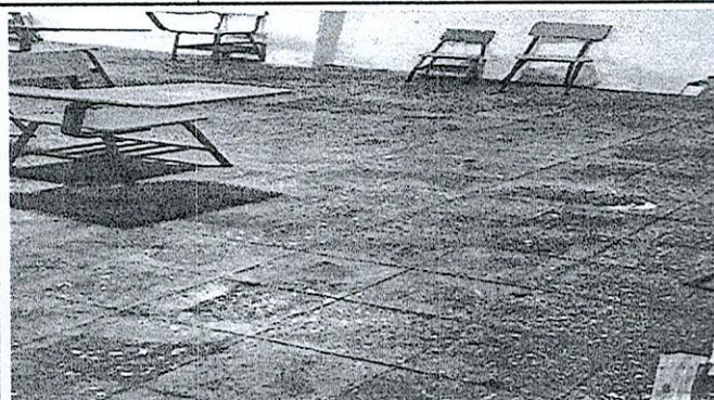
Foto 1: Sustrucción de piso de granito por piso cerámico en aulas primer nivel.
