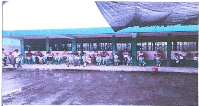
Foto 4: Se realizara intalación de piso antideslizante en area de servicios multiples
