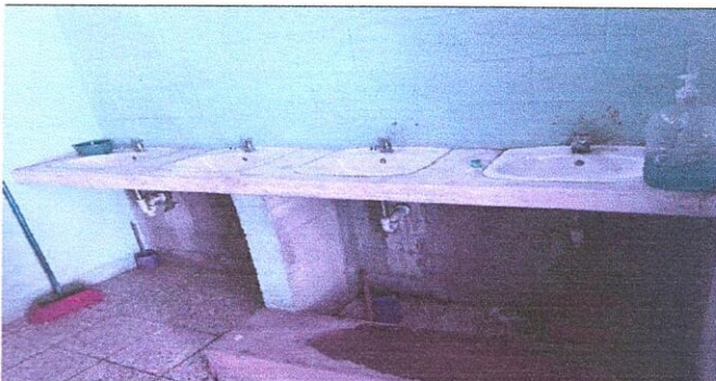
Foto 6: Se realizara la sustitución de mueble se lavamanos por mueble de de concreto con resvestimiento de azulejos.
