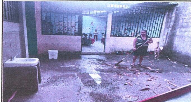
Foto 2: Se realizara la reparación de losa de patio de concreto por losa de patio de concreto
