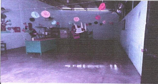
Foto1: Se realizara la sustitución de cubierta de lámina troquelada aluzinc calibre 26
