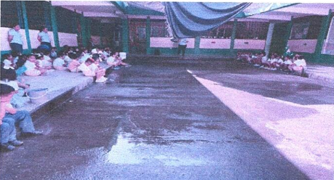
Foto 3: Se realizara intalación de piso antideslizante en area de servicios multiples
