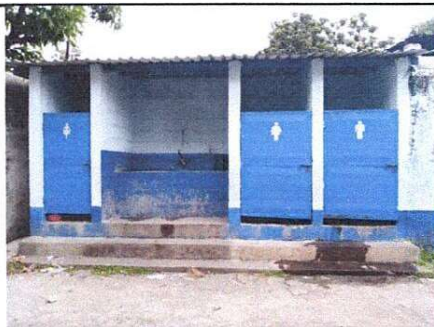
Foto 5 : SUSTITUCIÓN DE INODOROS + SUMINSTROS DE AZULEJOS Y APLICACIÓN DE PINTURA
