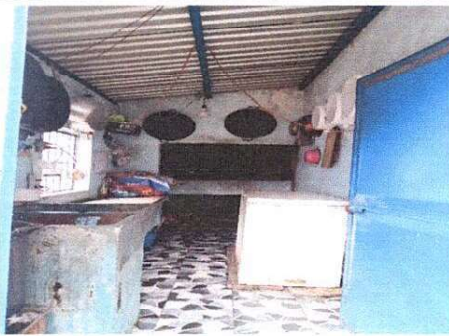
Foto1: MANTENIMIENTO A CUBIERTA DE COCINA
