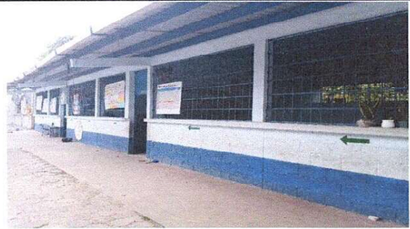
Foto 2: MANTENIMIENTO A BALCONES
