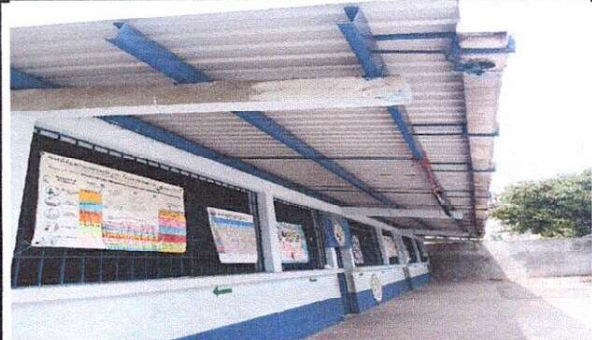
Foto 4: SUSTITUCIÓN DE CANAL DE BAJADA DE AGUA PLUVIAL
