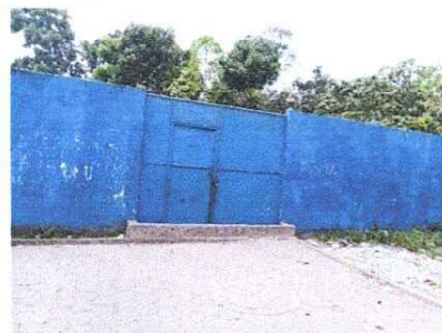
Foto 6: MANTENIMIENTO DE PORTON APLICACIÓN DE PINTURA
