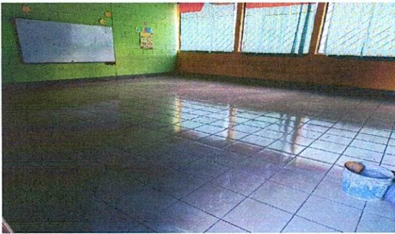
Foto1: sustitución de piso de tortas de concreto por piso cerámico
