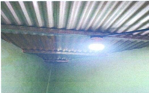
Foto 3: Sustitución de estructura de soporte por de madera por estructura de metal
