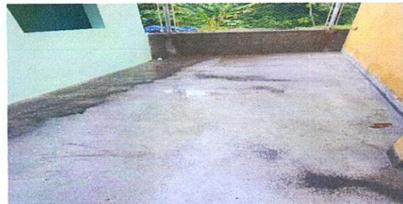
Foto 6: sustitución de losa de patio
