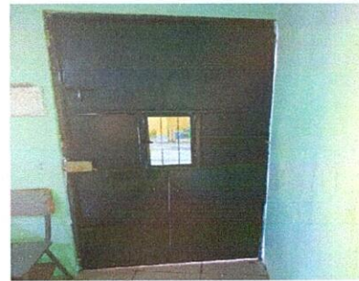
Foto 2: sustitución de puerta de madera por puerta de metal
