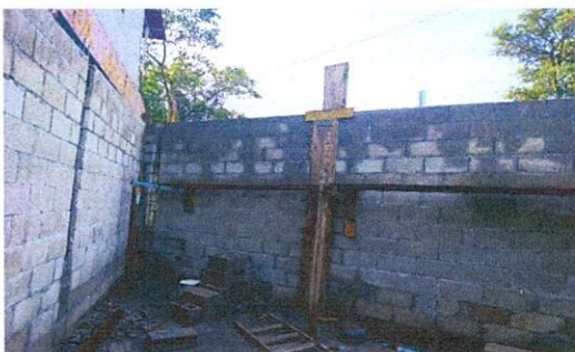
Foto 5: Sustitución de cerramiento de lamina existente por continuación de levantado de muro de block
