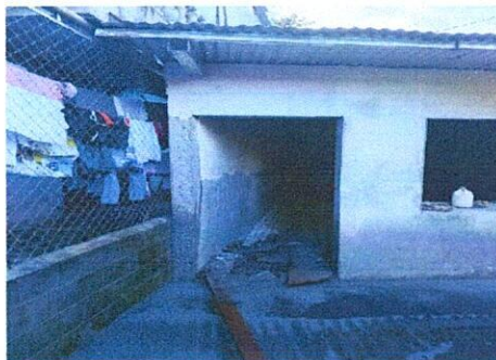
Foto 2: sustitución de puerta de madera por puerta de metal
