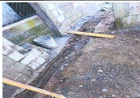
Foto 6: sustitución de losa de patio
