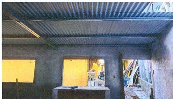
Foto 3: Sustitución de estructura de soporte por de madera por estructura de metal
