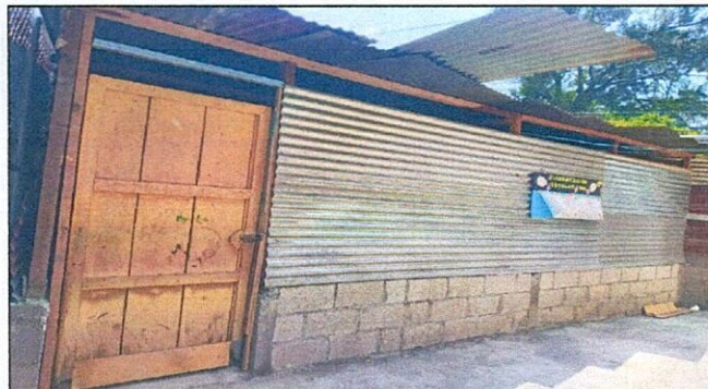
Foto 3: Sustitución de estructura de soporte por de madera por estructura de metal
