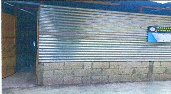
Foto 1: sustitución de piso de tortas de concreto por piso cerámico
