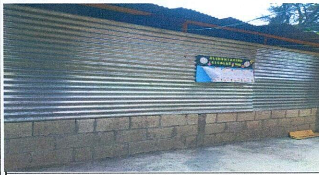
Foto 5: Sustitución de cerramiento de lamina existente por continuación de levantado de muro de block
