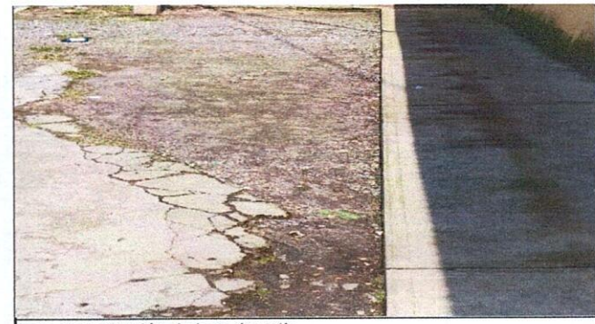
Foto 6: sustitución de losa de patio
