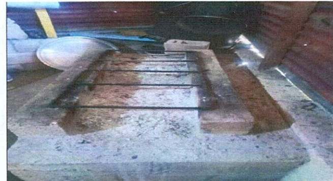
Foto 4: Sustitución de polleton de cocina por estufa rural con chimenea y plancha de metal
