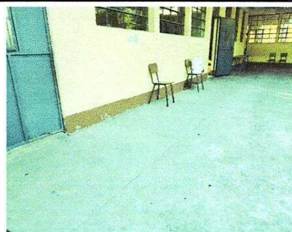
Foto 3: aplicación de pintura en muros, mantenimiento a puerta, sustitución de ventanas a PVC y sustitución de piso de concreto a piso cerámico.
