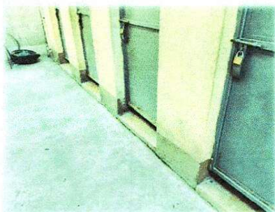
Foto 5: mantenimiento a puerta de metal aplicación de pintura anticorrosiva
