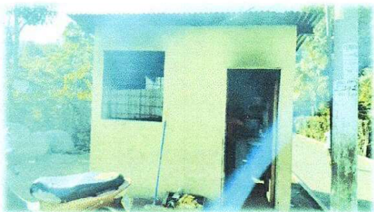
Foto1: Suministro de ventana PVC, sustitución de puerta de madera por metal y sustitución de estructura y lámina modulo cocina
