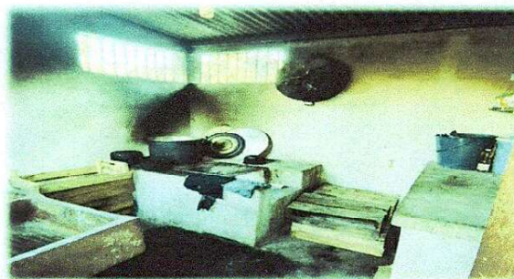
Foto 2: colocación de azulejo, suministro de chimenea, sustitución de pila por pila 0.70 x 1.50 modulo cocina
