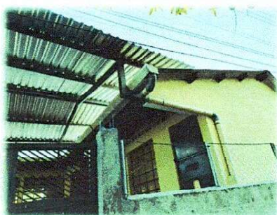
Foto 3: Mantenimiento a estructura de metal, reparación de canal, bajada pluvial y suministro de tubo galvanizado con angular en cerca perimetral.
