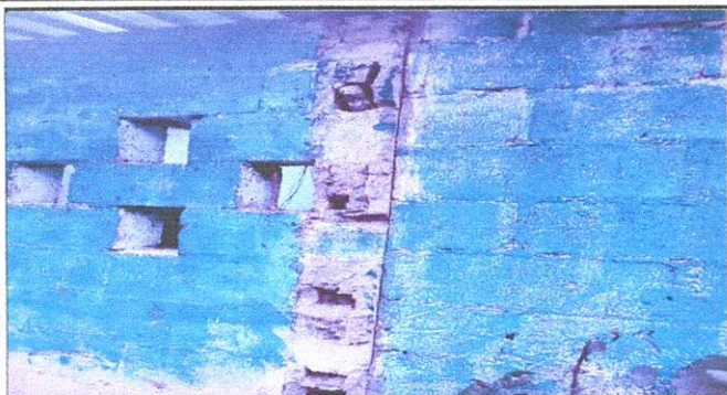
Foto 1: Se realizará la reparación de muros en área de cocina
