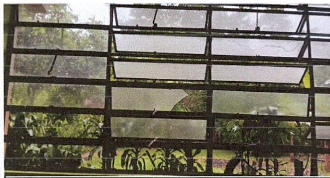
Foto 5: SE REALIZATRA LA SUSTITUCIÓN TIPO BALANCIN POR VENTANAS PVC EN MODULOS DE AULAS
