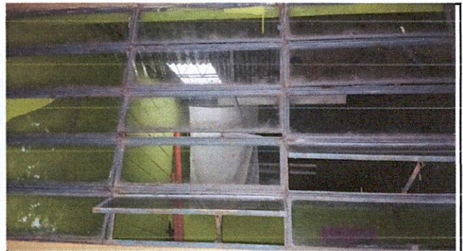
Foto 4: SE REALIZATRA LA SUSTITUCIÓN TIPO BALANCIN POR VENTANAS PVC EN MODULOS DE AULAS
