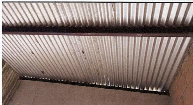
Foto1: Sustitución de cubierta de lámina existente por lámina troquelada aluzinc calibre 26
