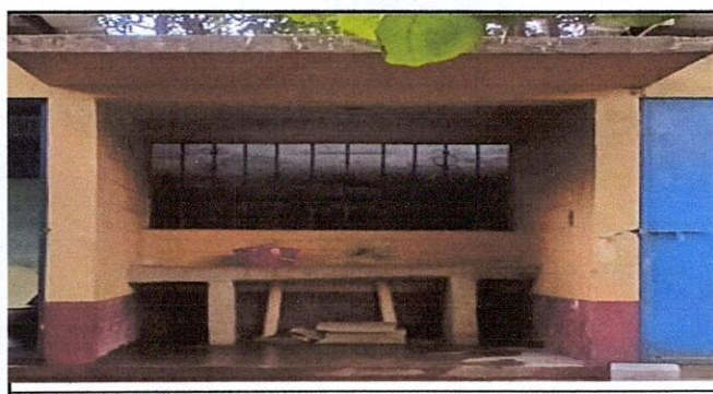
Foto 6: Se realizara la sustitución de lavamanos de concreto por lavamanos de concreto + instalacion de tres grifos.
