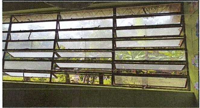
Foto 2: SE REALIZATRA LA SUSTITUCIÓN TIPO BALANCIN POR VENTANAS PVC EN MODULOS DE AULAS
