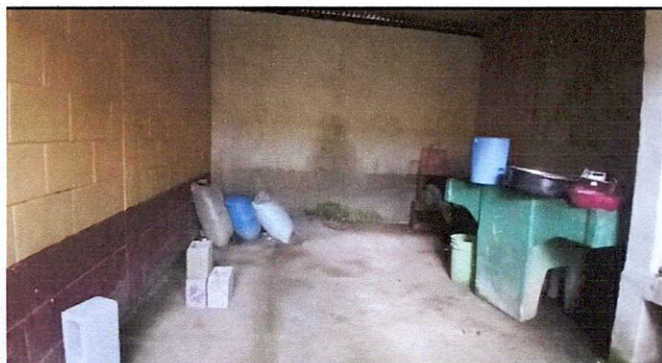
Foto 3: Se realizara la instalación de piso ceramínico en cocina como la elaboración de muebles de trabajo de concreto con revestimiento de azulejo.
