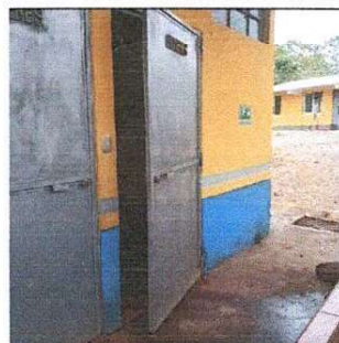
Foto 6: Sustitución de chapa
