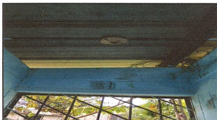
Foto 3: Sustitución de focos por focos LED ahorradores de 50W en area de cocina y servicios sanitarios
