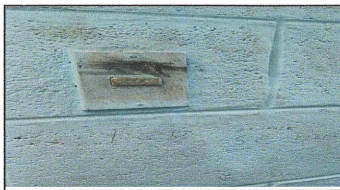
Foto 4: Se realizara la reparación y sustitución de simples por interruptores dobles
