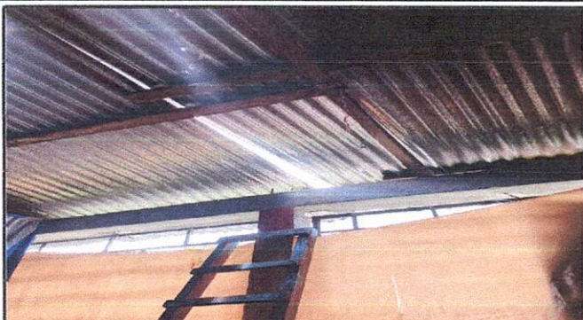
FOTO 1: Sustrucción de lámina acanalada por lamina troquelada
