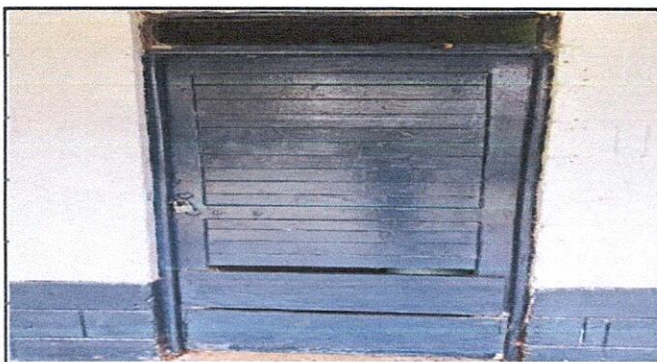
FOTO 3: Sustrucción de puerta por puerta de metal
