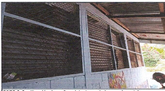
FOTO 5: Sustrucción de maña existente por balcones de metal
