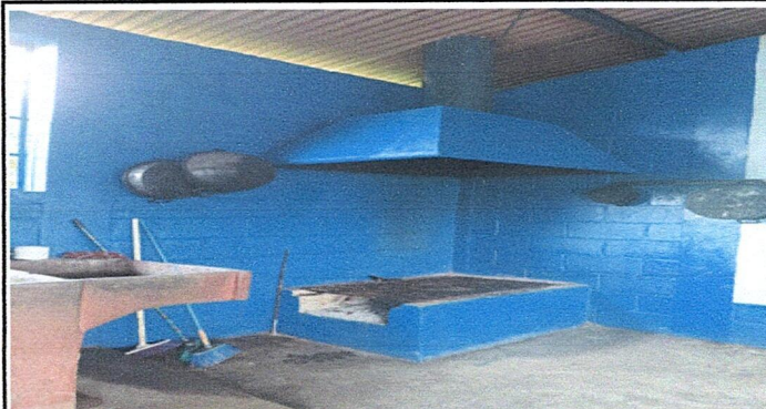
Foto 8: Pintura en interior de area de cocina y mantenimiento a chimenea
