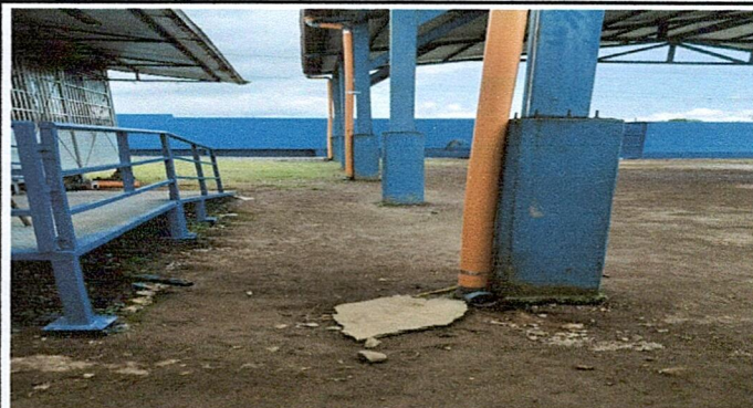
Foto 2: Reparación de bajada de agua plubial, tubo PVC 4".
