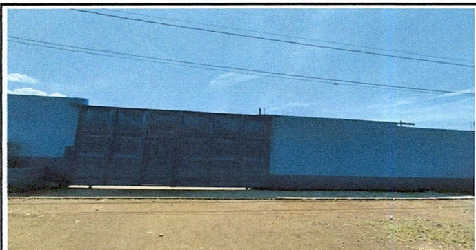
Foto 5: Mantenimiento de portón.
