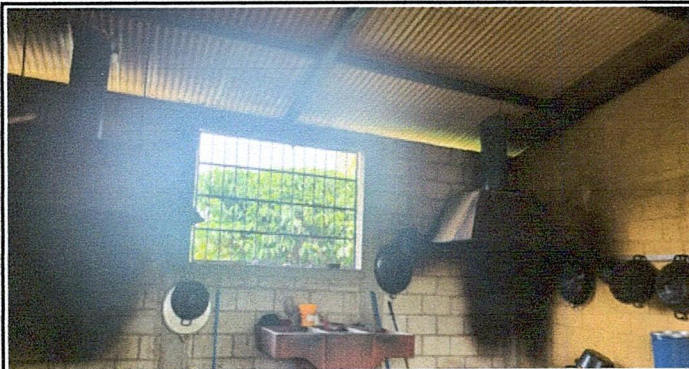
Foto 7: Pintura en interior de area de cocina y mantenimiento a chimenea
