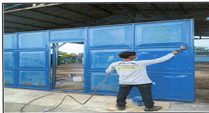
Foto 5: Mantenimiento de portón
