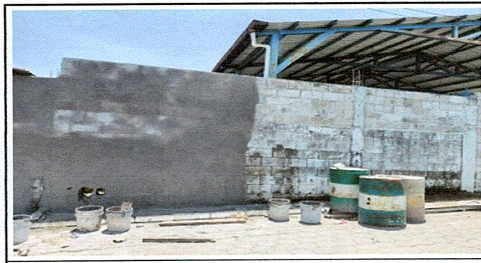
Foto 6: Repello en muro perimetral
